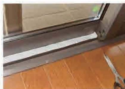
▲隙間シートで目張り
