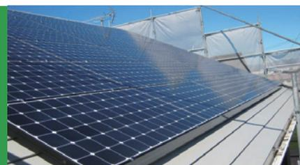
Q CELLS 設置枚数52枚/システム容量 18.460kW | 予想年間発電量 = 21,336kWh | 月間平均発電量 = 1,778 kWh
