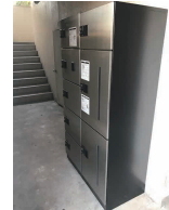
宅配ボックス新設
